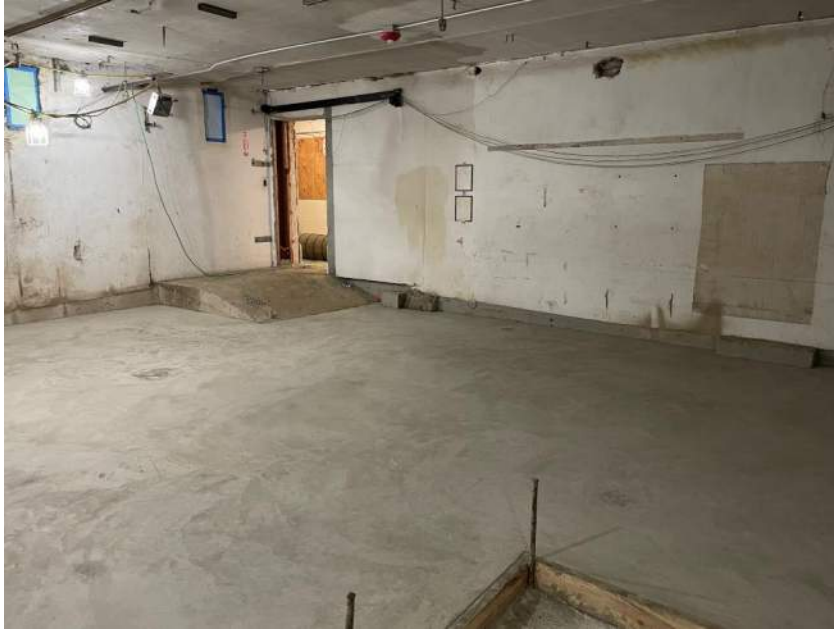
CHHS – Boiler room slab pour back
