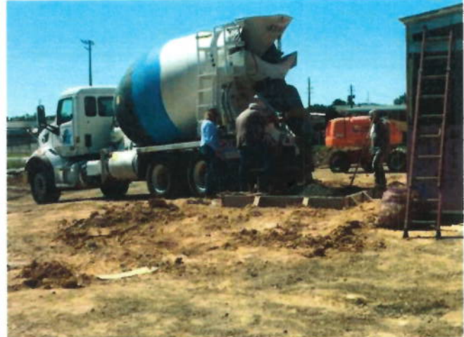
4. Concrete pour at electrical transformer pad
