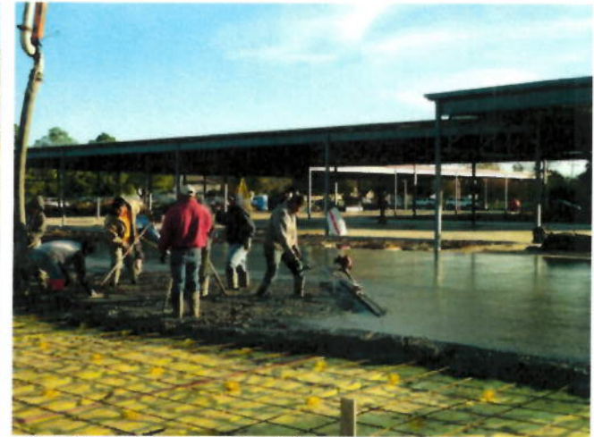
2. Concrete pour at cafeteria
