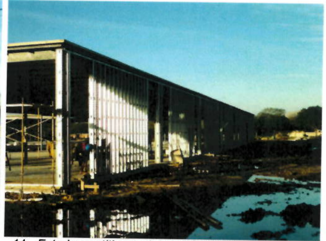
14. Exterior partition metal stud framing
