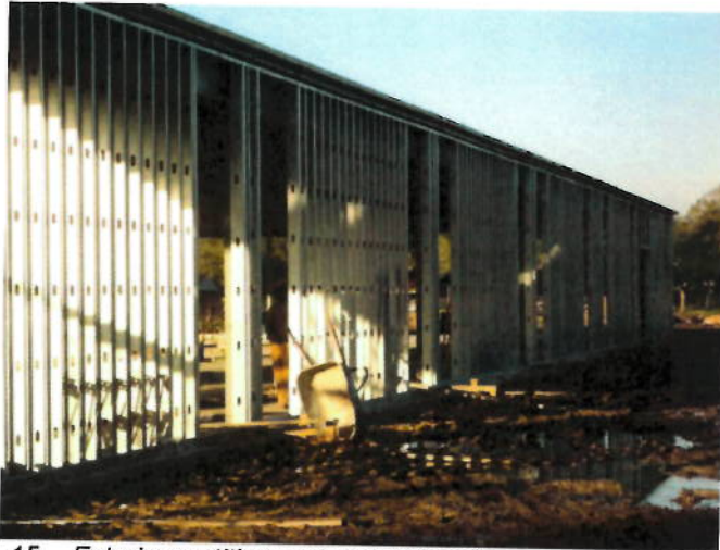
15. Exterior partition metal stud framing
