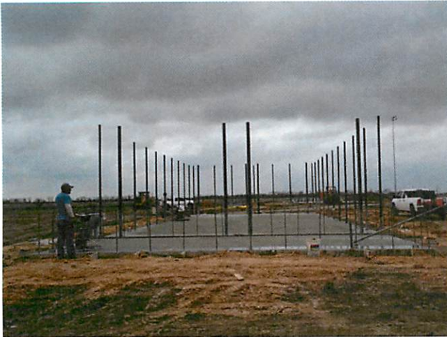
13. Baseball batting cage concrete pour
