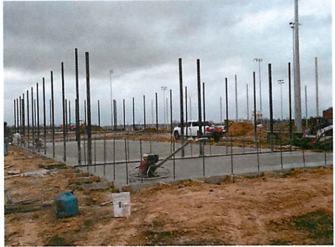
14. Baseball batting cage concrete pour
