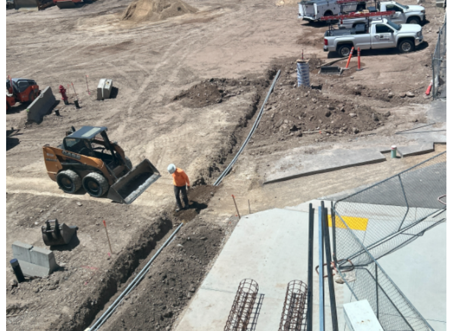
Electrical conduit installation
