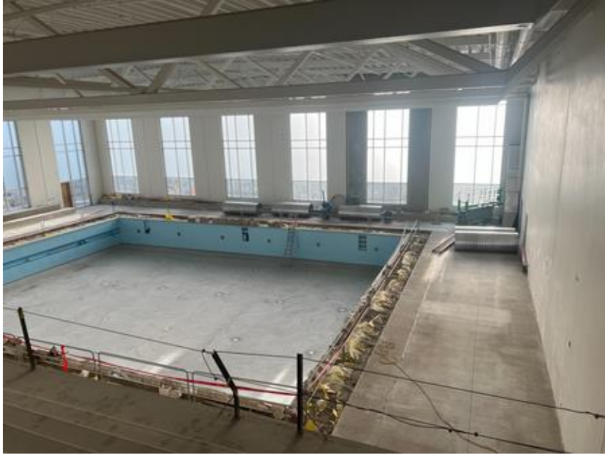
Pool deck pour in progress
