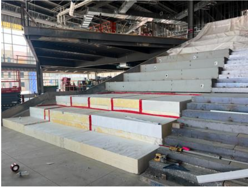
Learning Stairs framed for concrete pour
