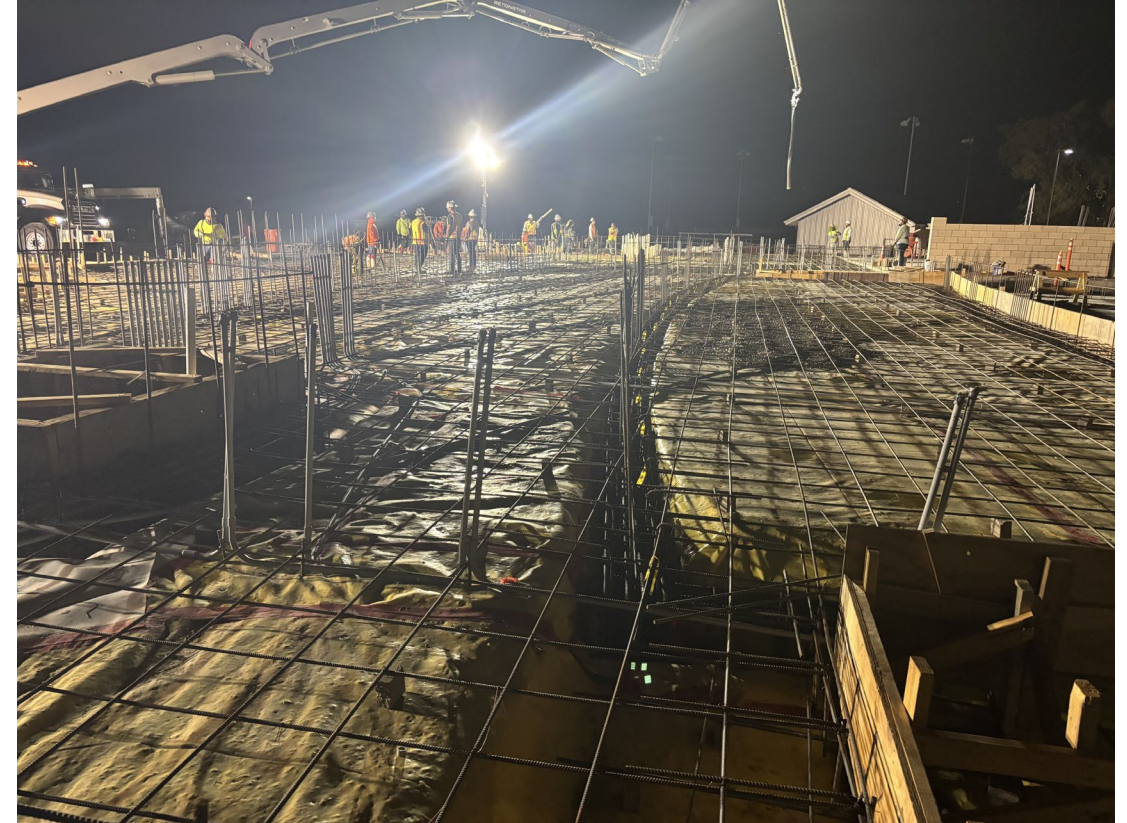
Photo: Slab Pour @ Performing Arts
