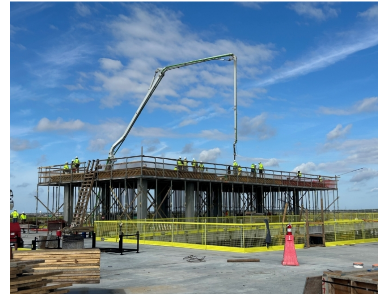
Last concrete pour for the structure, penthouse.
