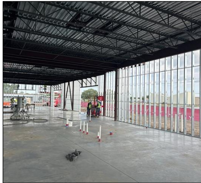
Exterior metal stud framing
