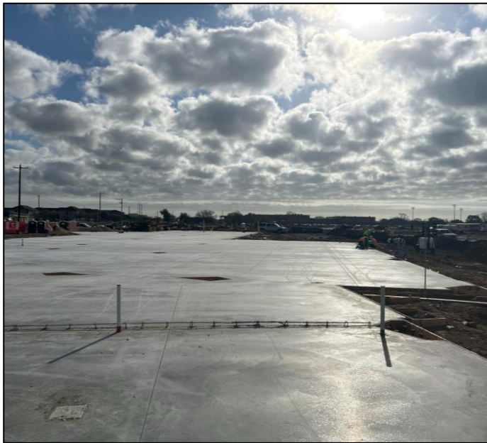
Building slab concrete pour
