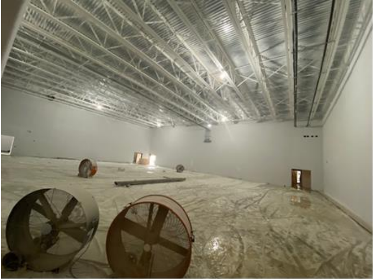
Intumescent Paint & Primer in Gym
