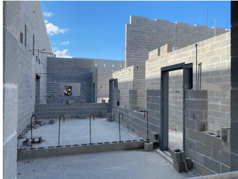
CMU & Door Frames in Area 4
