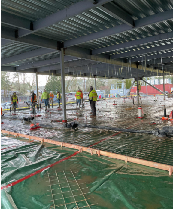
First Slab Pour
