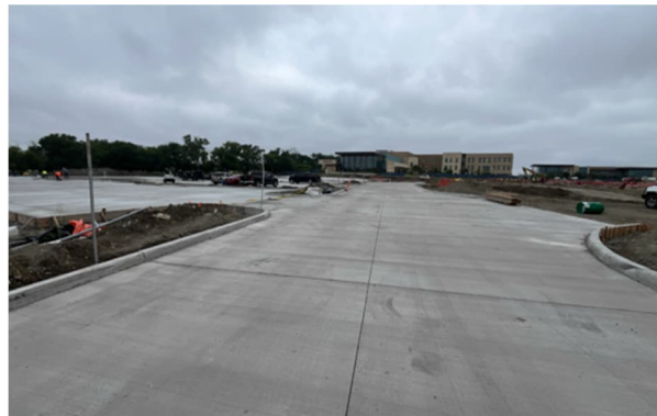
Fire Lane Partial Pour
