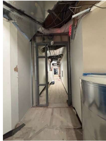
Door Frame Install Ongoing
