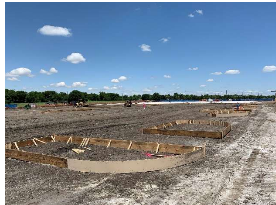
Parking Lot Prepped for Pour
