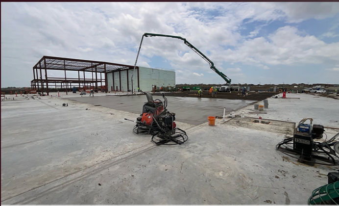
FINAL FIRST FLOOR SLAB POUR
