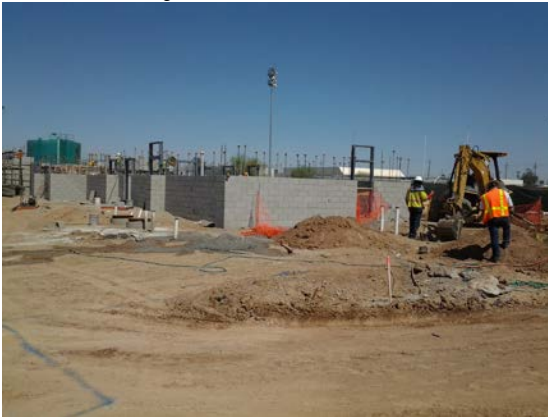
New PE Building Exterior Masonry
