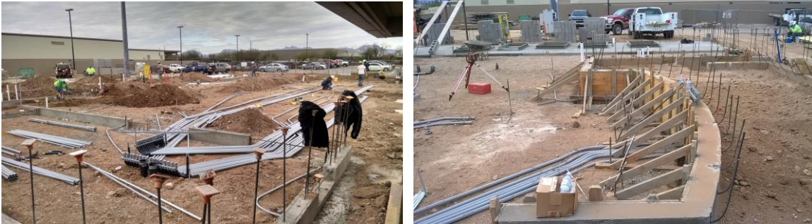
Underground Conduit Installation
