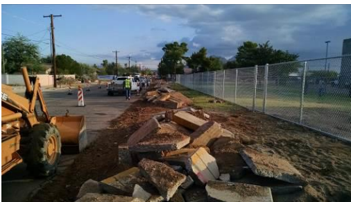
Keeling Sidewalk & Curb
