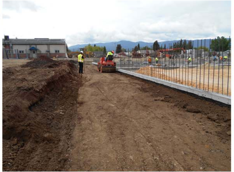
08. Site Visit 05.29.18.JPG
