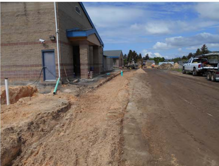
11. Site Visit 05.29.18.JPG
