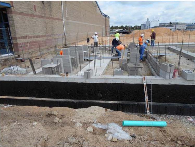
03. Site Visit 05.29.18.JPG
