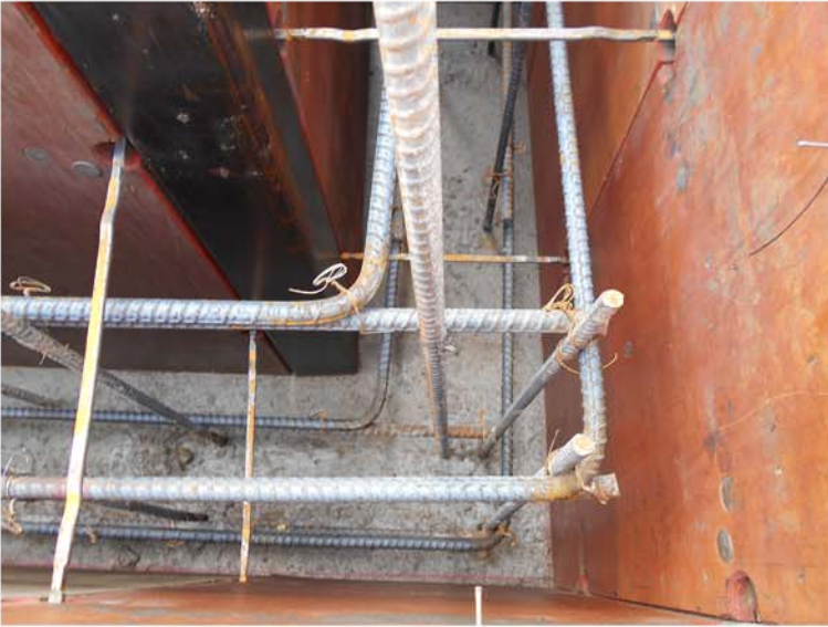
13. Site Visit 05.29.18.JPG
