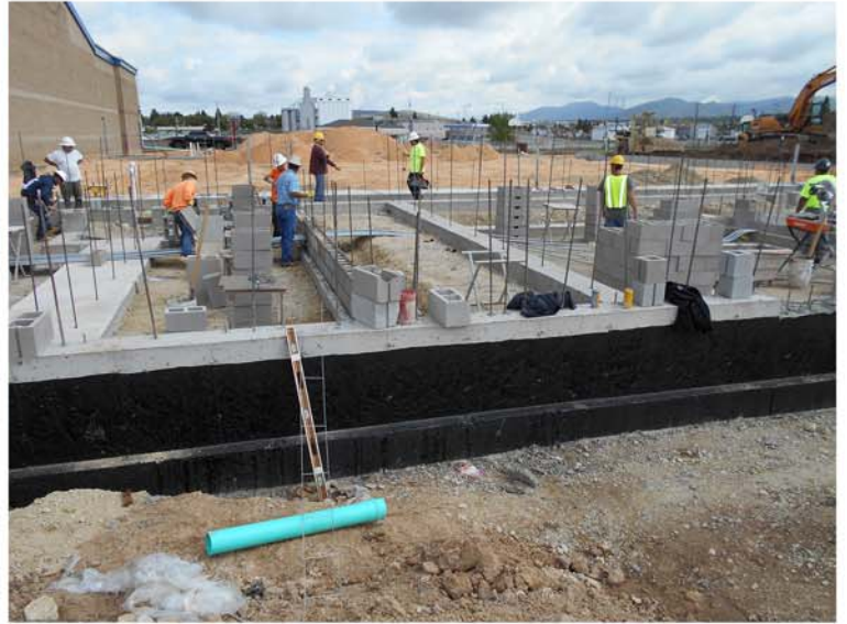
02. Site Visit 05.29.18.JPG
