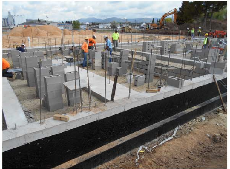
04. Site Visit 05.29.18.JPG
