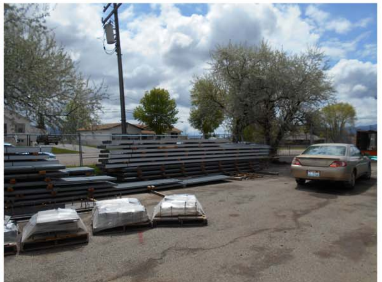
18. Site Visit 05.29.18.JPG
