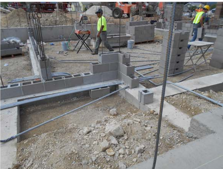
05. Site Visit 05.29.18.JPG
