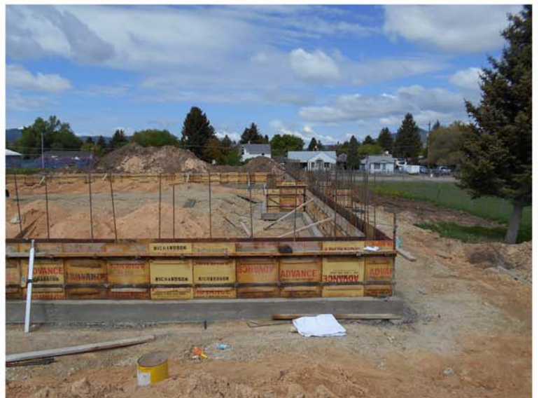
12. Site Visit 05.29.18.JPG
