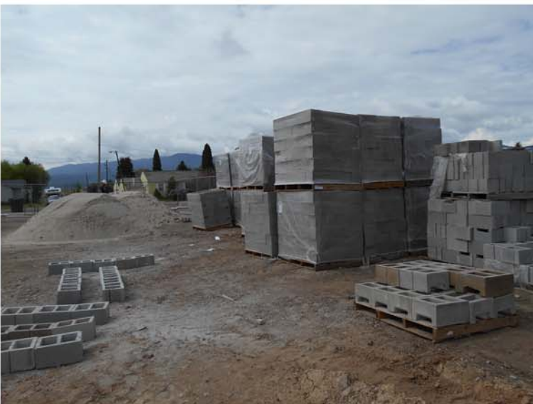
17. Site Visit 05.29.18.JPG
