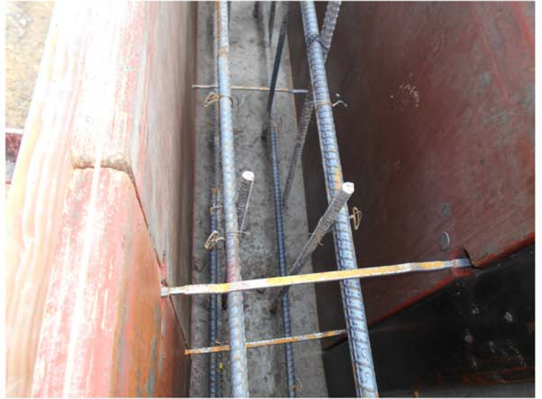
14. Site Visit 05.29.18.JPG
