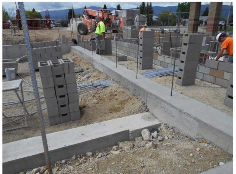
06. Site Visit 05.29.18.JPG
