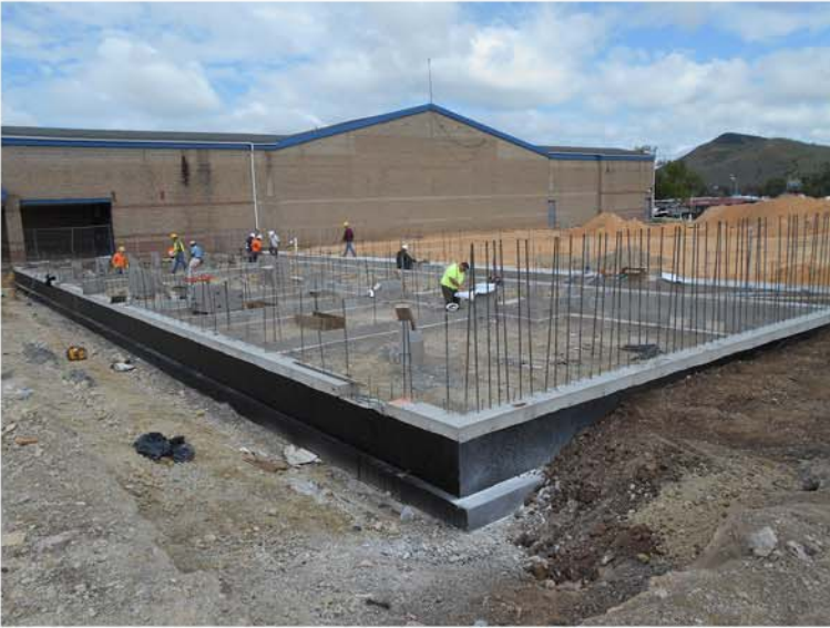
01. Site Visit 05.29.18.JPG
