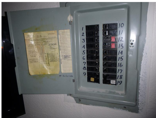
Photo E2– Murray Loadcenter
