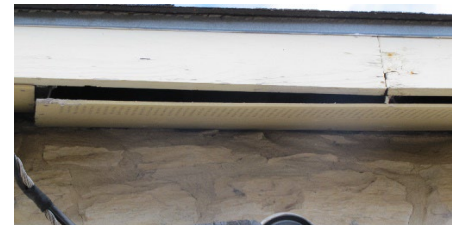
Loose soffit
