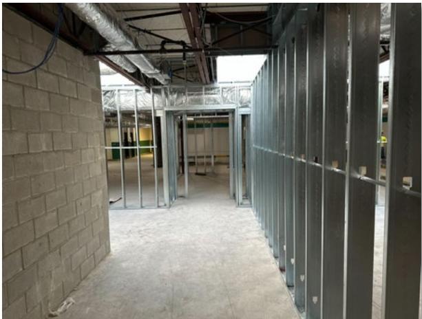
Metal Stud Framing #5
