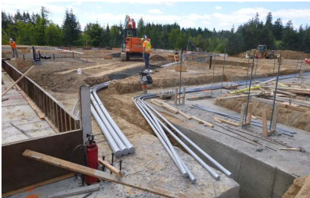
Electrical conduit installation
