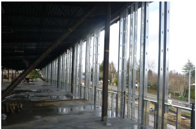
Exterior wall metal stud framing
