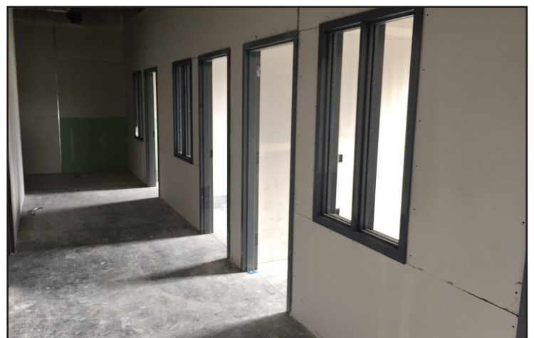
Main office door frames
