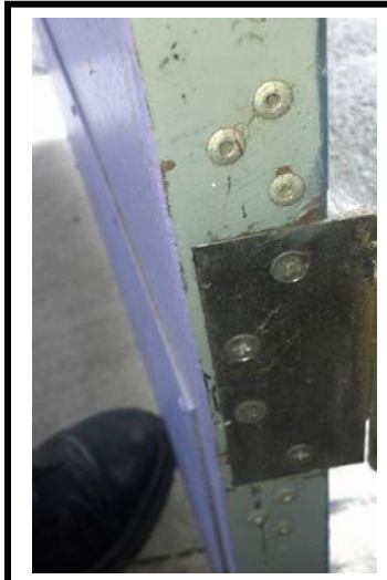
Broken Door Hinge Bracket
