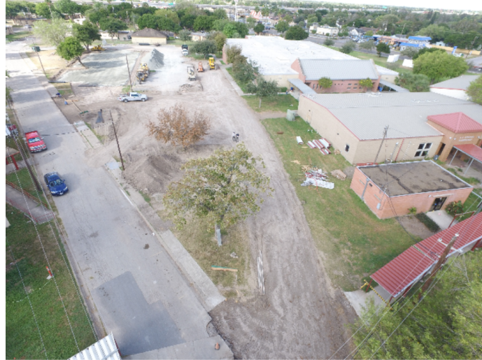
Canales ES Parking, Roof & Canopies
