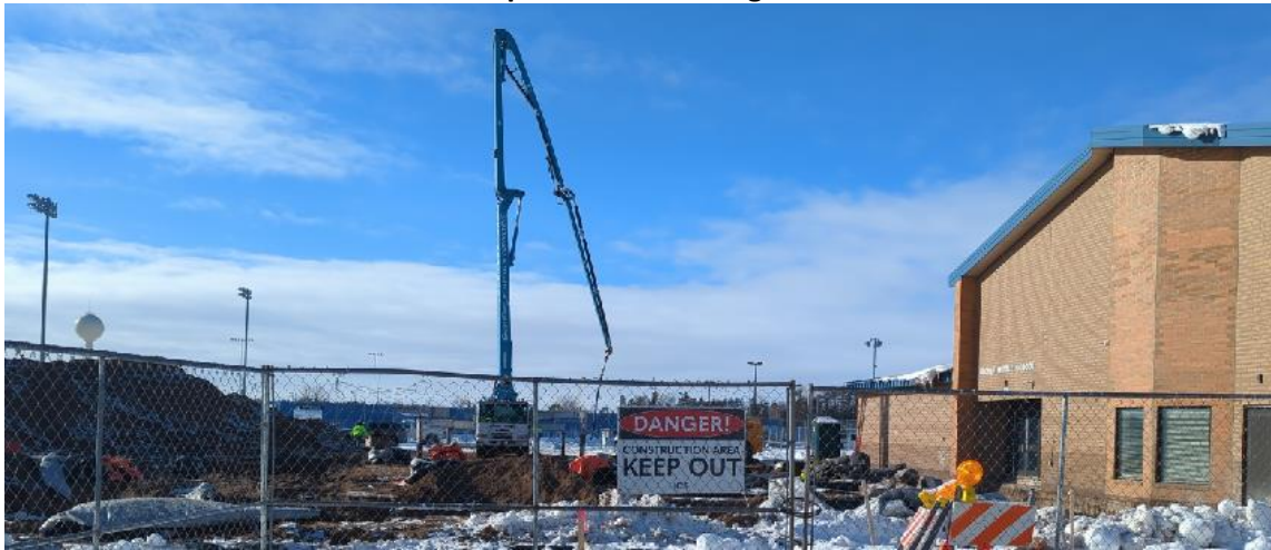
Pump Truck for Footing Pour
