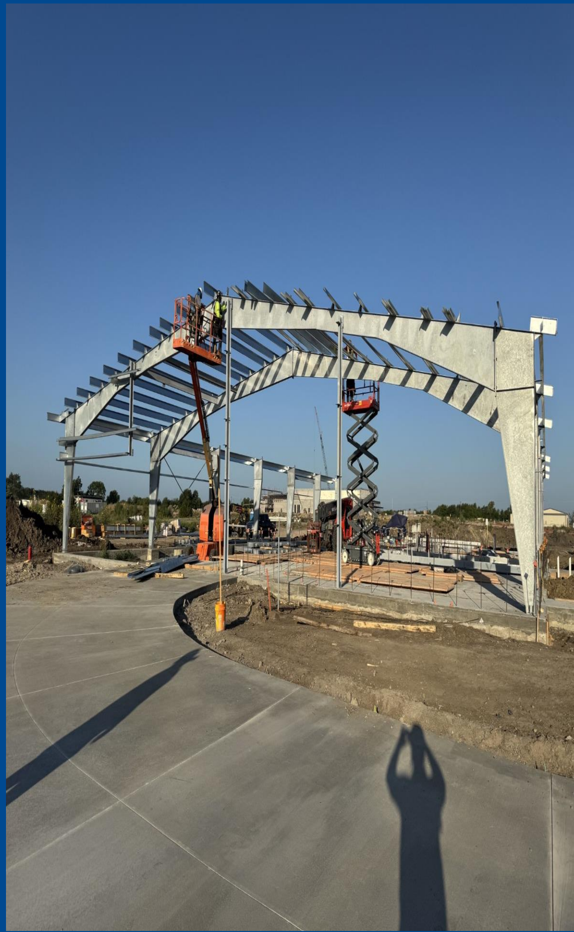
Ag Barn Install
