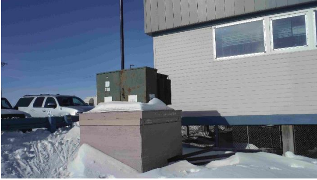
Photo E1–Service Transformer
