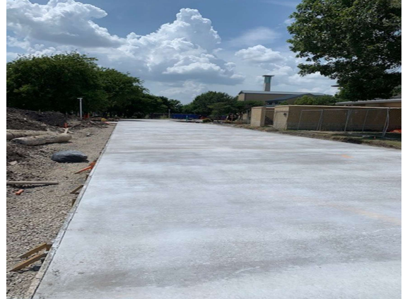
Fire Lane Poured
